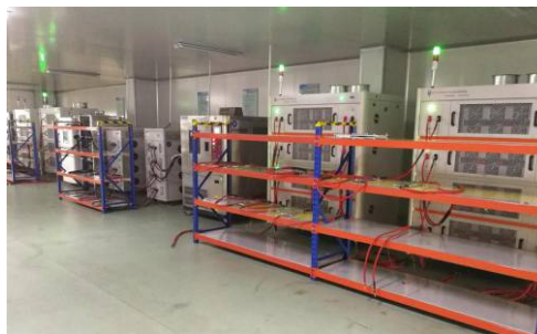
电性能实验室 Electrical performance lab
